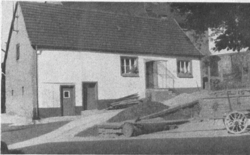
Abb. 8: „Arbeiterbauernhaus“ in Dörrenbach. — Eine Scheune fehlt. Heu und Stroh werden in dem stark heruntergezogenen Speicher gelagert.
